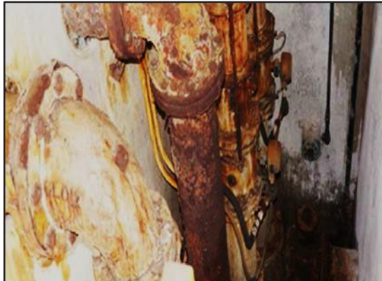
Tuberías corroídas.
